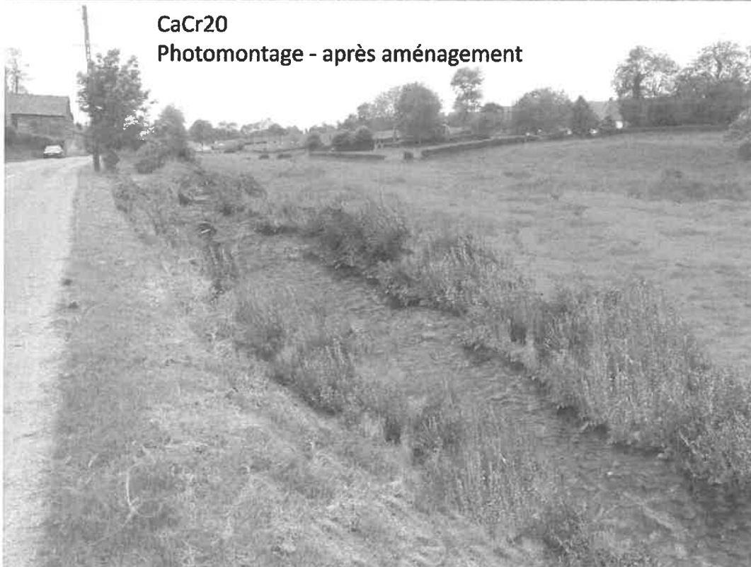
Figure 7. Photomontage avant et après travaux
