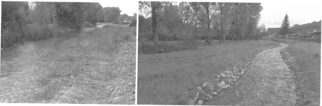
Figure 5. Réalisation de terrassement du lit sur des chantiers (chantier Cariçaie)
